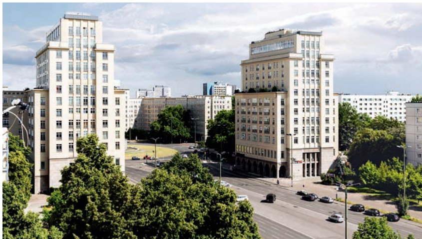
Central Berlin: Wer sich eine Wohnung in den Arbeiterpalästen am Strausberger Platz nicht leisten kann, kann auch anders vom Immobilienboom der Hauptstadt profitieren – für die Renovierung des Ensembles wird auch Schwarmkapital eingesetzt
